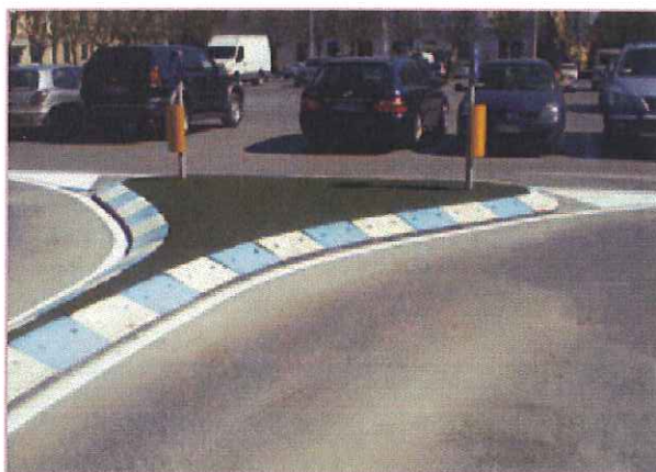
Rotonda diam. 200 cm, altezza 10 cm, composta da n. 4 elementi a spicchio dotati di idonei alloggiamenti per i tasselli di fissaggio.
