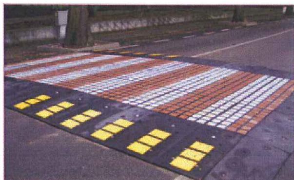
Comune di Marmirolo: attraversamento pedonale rialzato con inserti in porfido quarzato, fissato alla pavimentazione mediante idonei tasselli.
